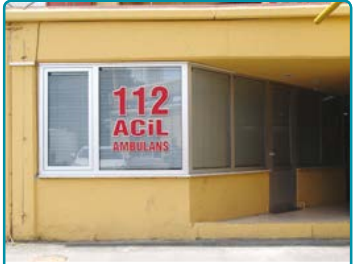
112 Acil Servis merkezi yenilendi.
